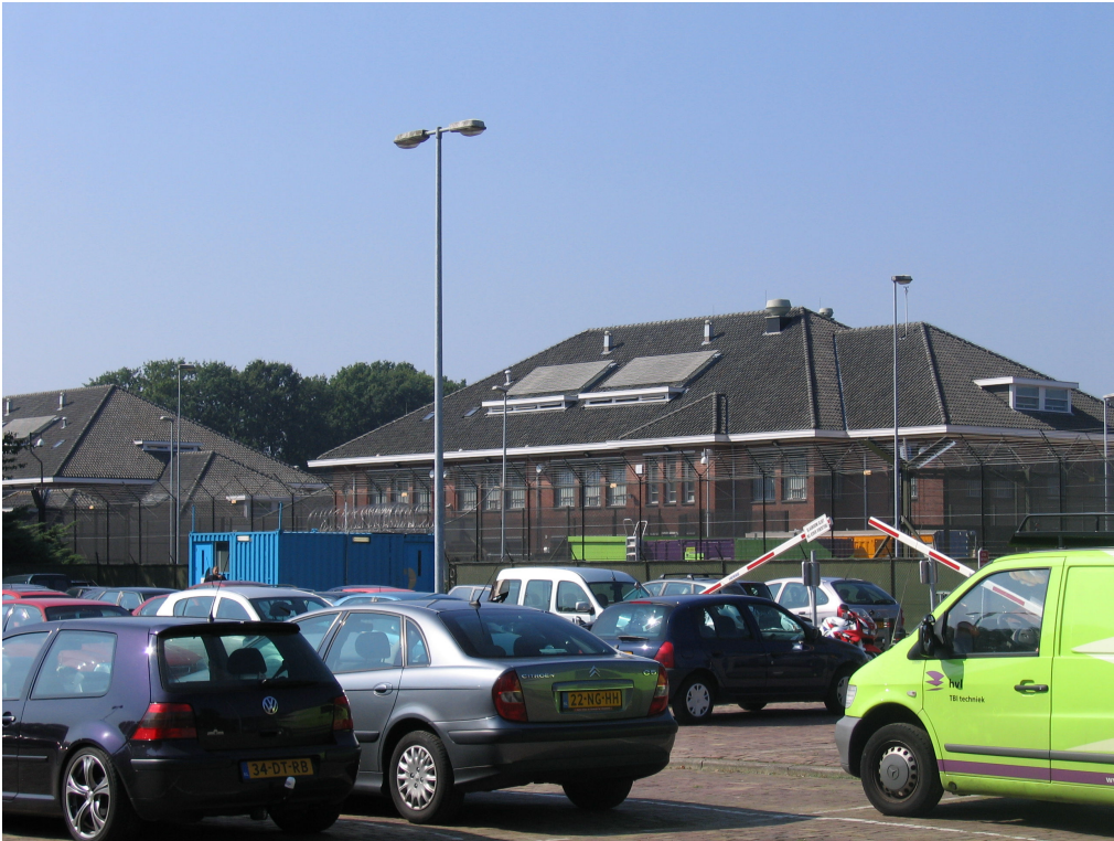
De Vreemdelingenbewaring van de PI Tilburg, gezien vanaf het parkeerterrein. / The Aliens Custody of the Tilburg Prison, seen from the car park.
